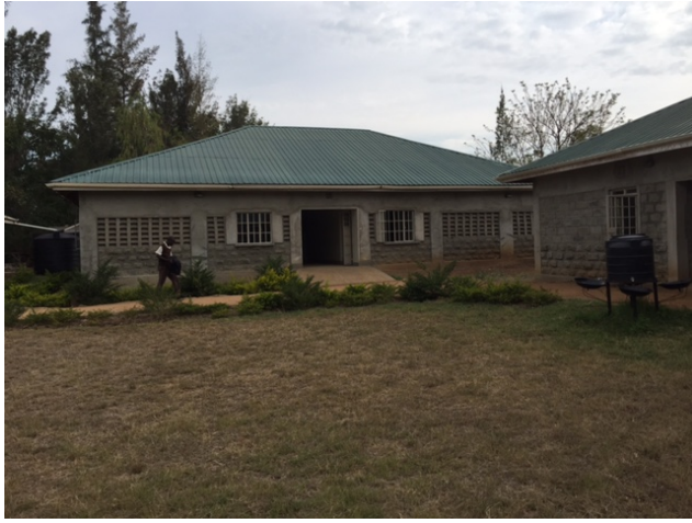
Atelier mécanique, plomberie et maçonnerie
