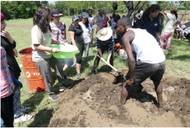
Mélanger la terre pour fabriquer le pisé
